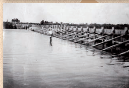
出津板羽目堰(昭和10年代)
