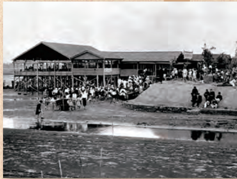
埋立前の八幡海岸(海の家)
