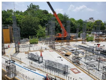
柱・壁配筋工事（R2.6.3）
