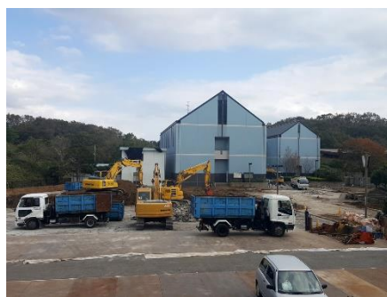
外構撤去工事（R1.11.8）
