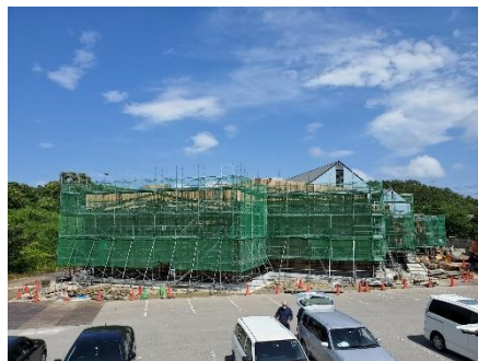
壁型枠工事（R2.6.26）
