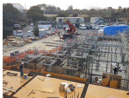
基礎配筋工事（R2.3.12）
