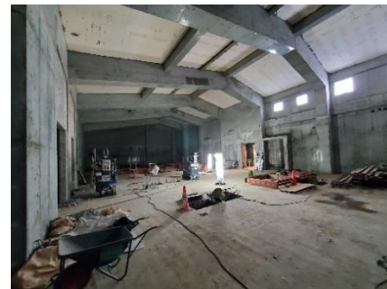
展示室足場撤去(2020.10.8)
