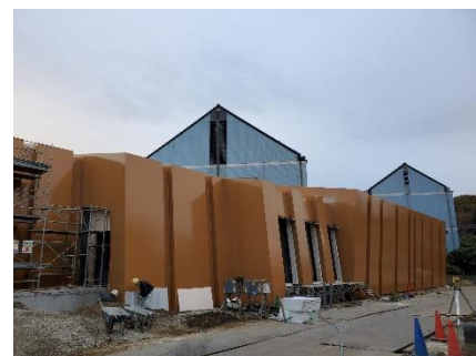
外部足場撤去 (2020.11.24)
