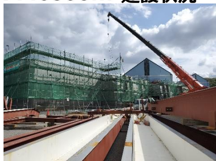
外壁鉄骨設置(2020.10.7)
