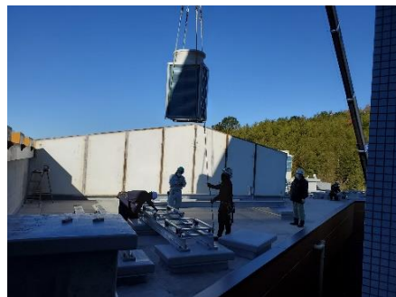
空調設備設置(2020.12.17)
