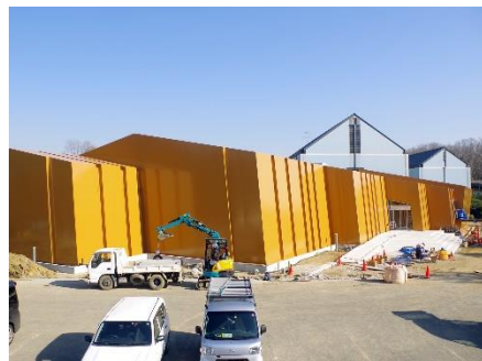
足場の取れた外観 (2021.1.21)
