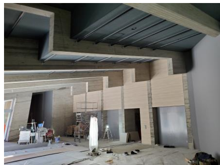
エントランス壁・床設置 (2021.1.20)
