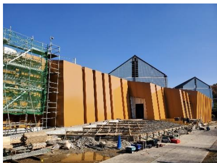
入口階段型枠設置(2020.12.7)
