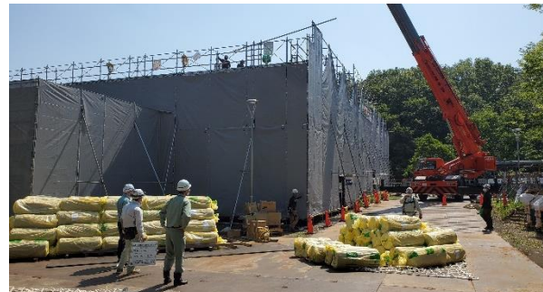
隣接する歴史体験館の改修工事も始まりました
