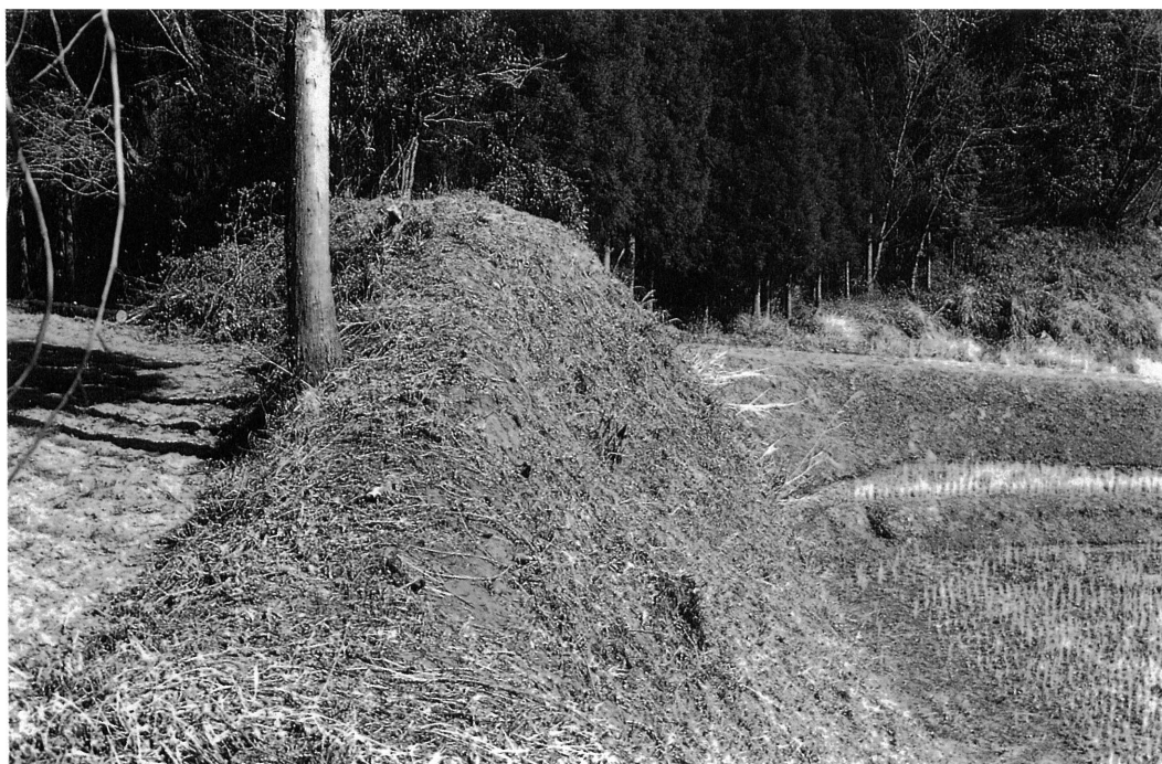
1. 南部外郭に残る土塁と削平地（西から）
