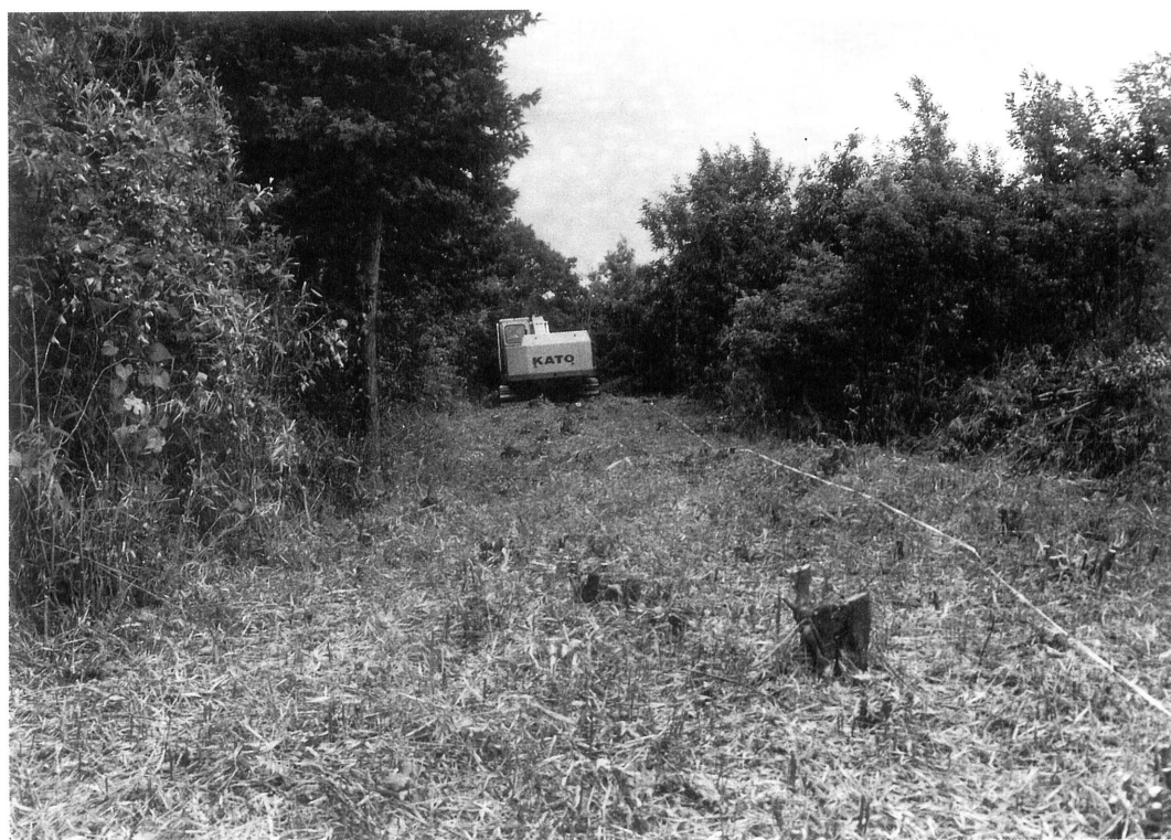
No. 2 トレンチ周辺現況
