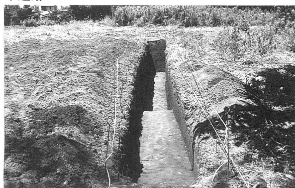
1 トレンチ東側より
