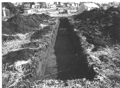
3 トレンチ(西から)
