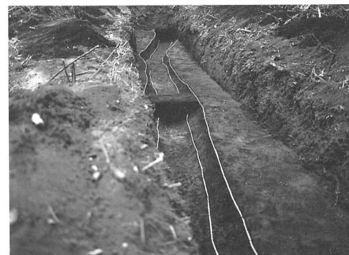
9 トレンチ検出 溝(西から)
