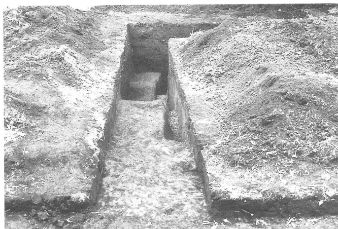
13号トレンチ全景
