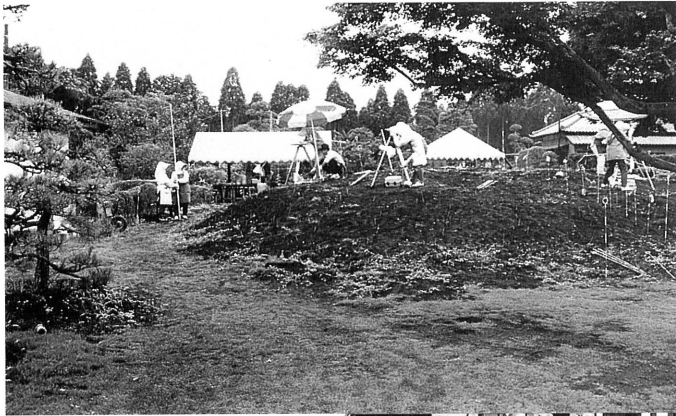
調査前の盛土 (北東から)
