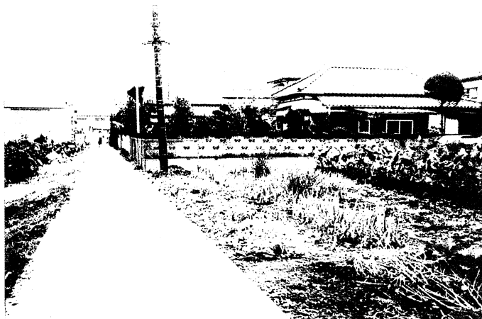
調査前近景（宅地部分）
