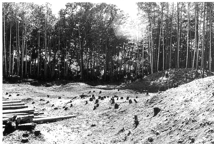
調査前近景 (北から)
