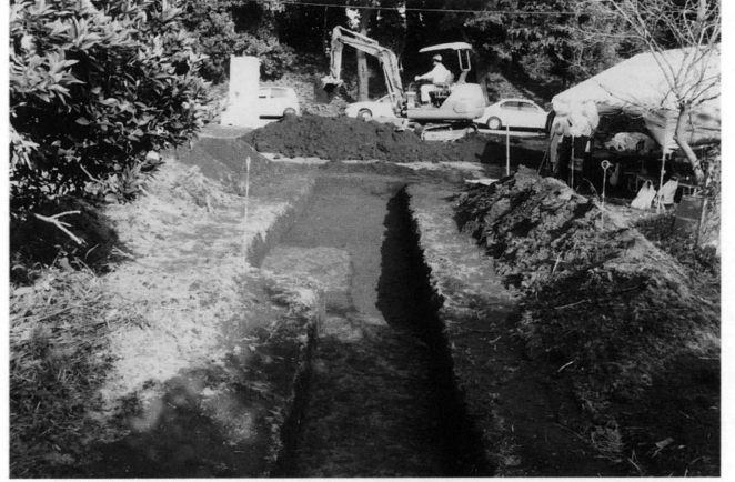
1 トレンチ検出状況
