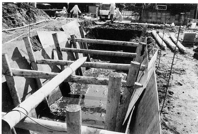
トレンチ掘削状況
