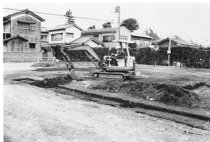
埋め戻し作業
