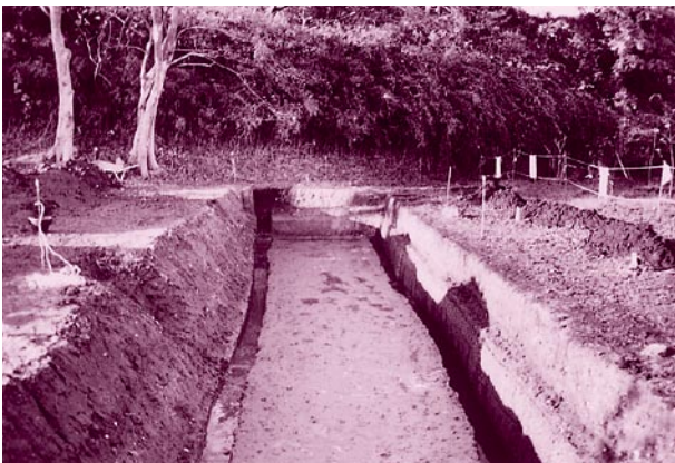
5 トレンチ作業風景
