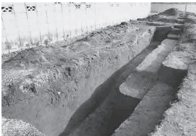
郡本遺跡群11次 1トレンチ001台地整形跡 西から
