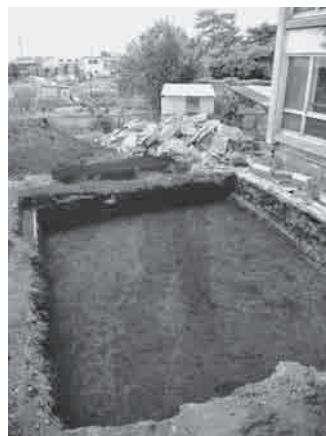
5 トレンチ 010 溝跡確認面 西から
