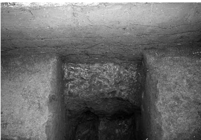
郡本遺跡群13次 3トレンチSD01 サブトレ2 北から
