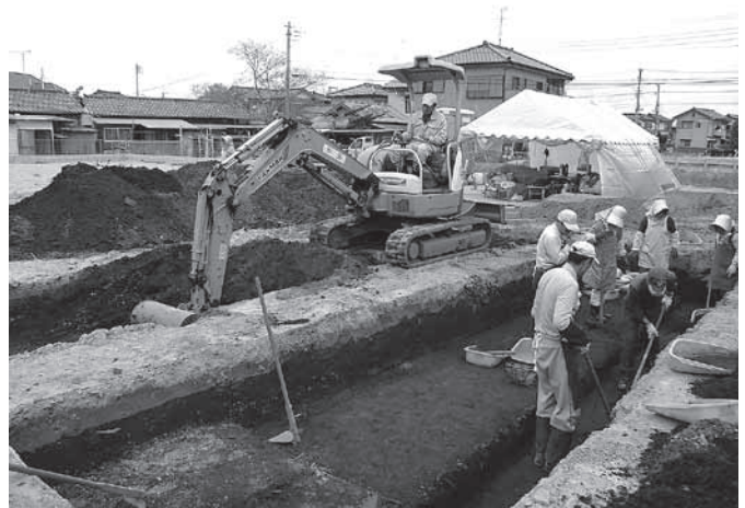
棗塚遺跡 表土掘削状況 南から
