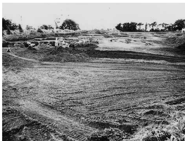
埋め戻し状況 2
