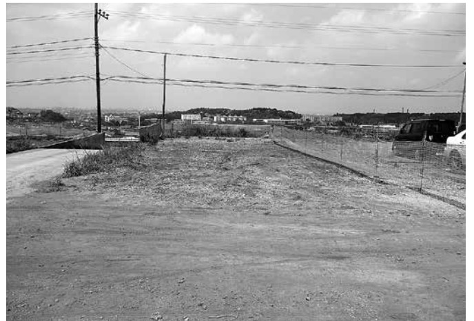
調査前の状況（北東側）
