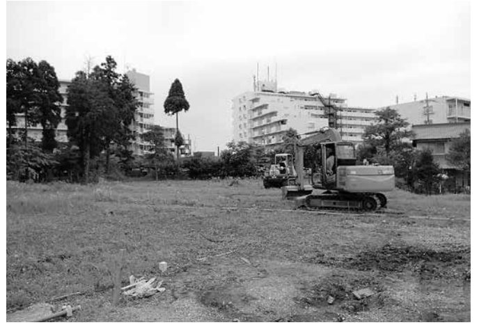
調査前の状況（南西側付近を北東側から望む）
