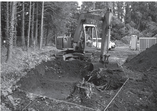
東調査区表土掘削状況
