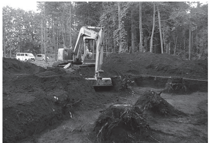
西調査区表土掘削状況
