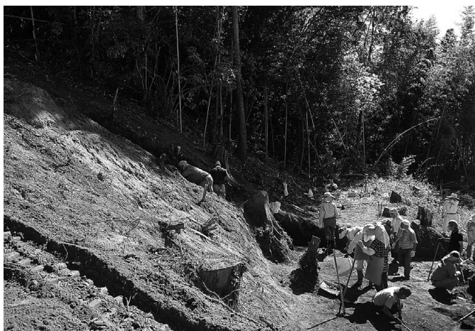
1号トレンチ 掘り下げ作業風景
