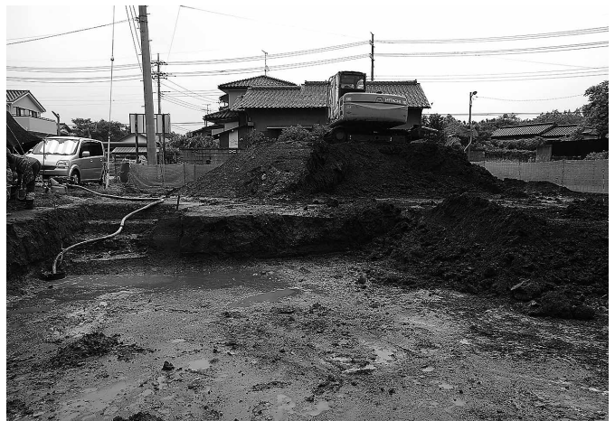
西野遺跡群 本調査範囲掘削・排水作業 (西から)
